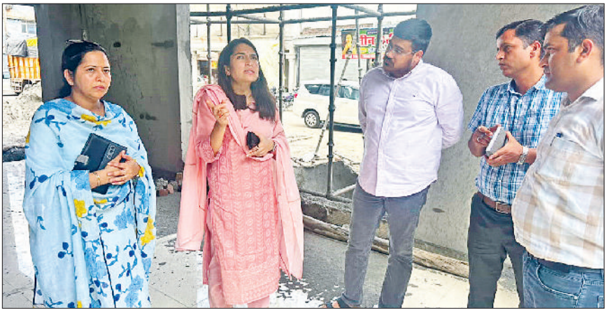
करनाल। निर्माणाधीन कॉमर्शियल स्पेस परियोजना का निरीक्षण करती नगर निगम आयुक्त सलोनी शर्मा।
